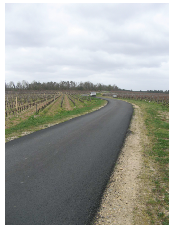
La réfection de la route du Caladis permet de diminuer de moitié le trafic de camions route du Courneau.
